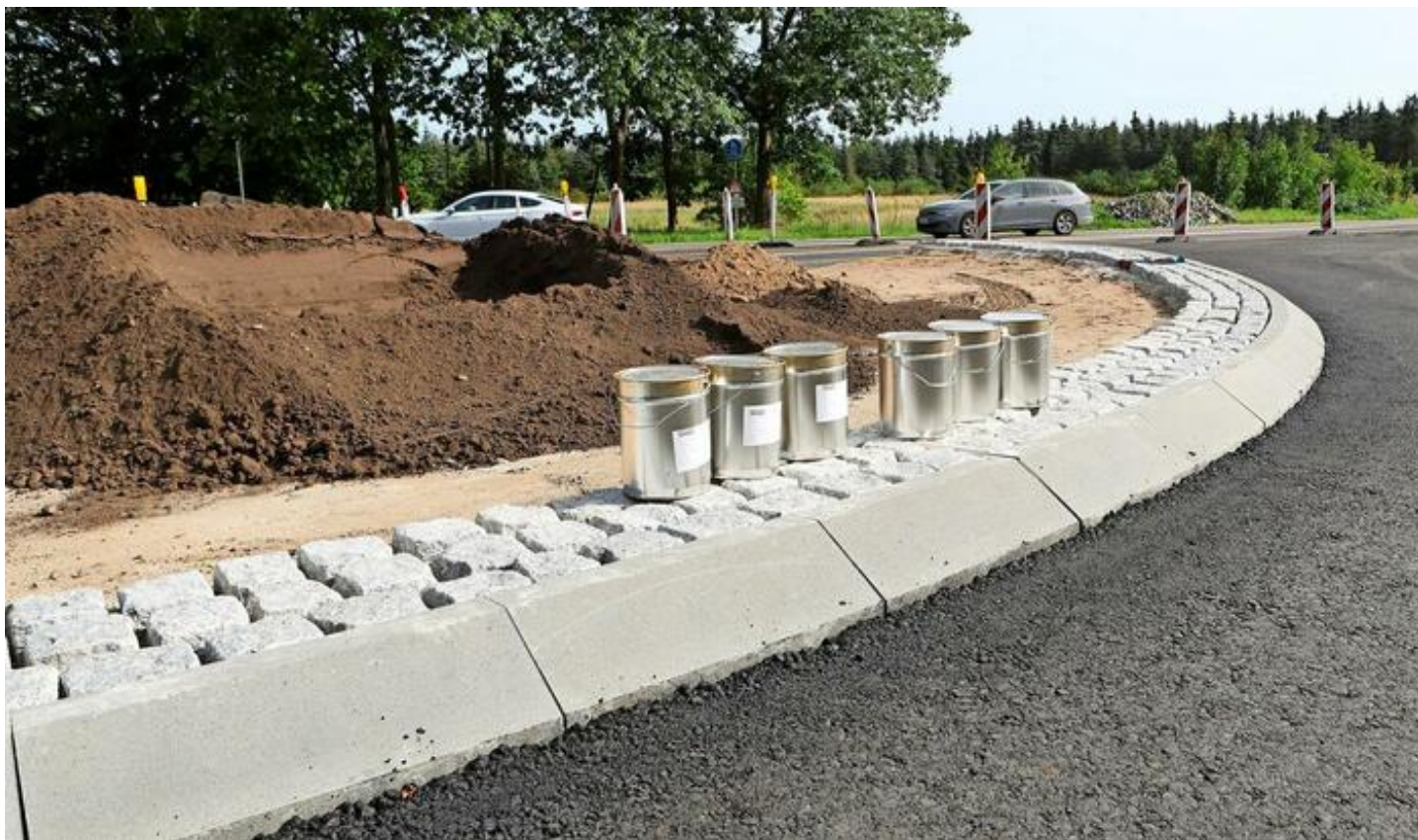
Kreiselbau an der Krümme: Die Arbeiten kommen voran, auch bei der Fahrbahnerneuerung nördlich davon. Foto: Lea Behrens
