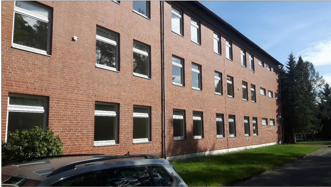
Abbildung 2: Gebäudebestand, bereits umgenutzt, im nordwestlichen Teil des Areals (eigene Bilder)
