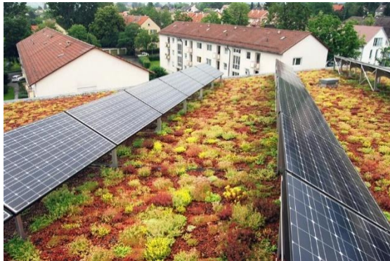
Abb. 31: Dachbegrünung und Photovoltaik in Kombination, Stadt Münster (ZinCo GmbH)
