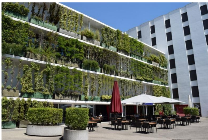
Abb. 35: Begrünung in Regalbauweise (BuGG, G. Mann)
